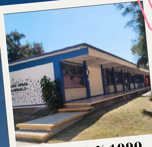
EDIFICIO N, 1990 LABORATORIO DE ELECTRÓNICA
