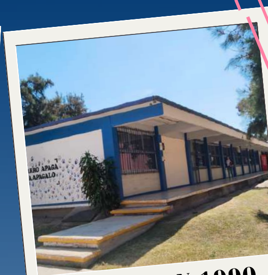
EDIFICIO N, 1990 LABORATORIO DE ELECTRÓNICA
