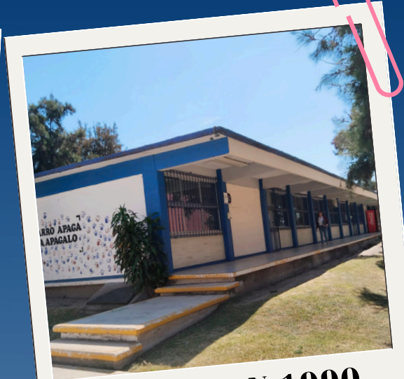
EDIFICIO N, 1990 LABORATORIO DE ELECTRÓNICA
